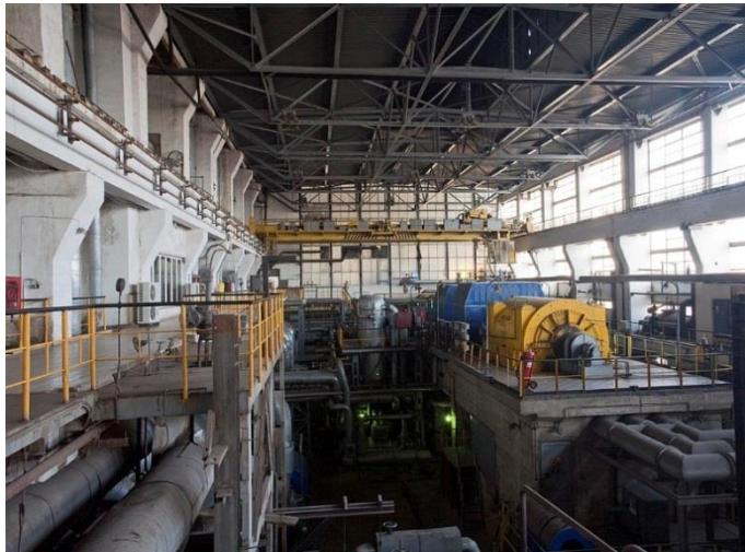
Sala turbinelor etapa a III a, se vede cu albastru carcasa turbinei de abur TA6 si cu galben generatorul electric cu puterea nominala de 50 MW; se vad bare capsule de evacuare a puterii electrice la tensiunea de 10.5 kV.
