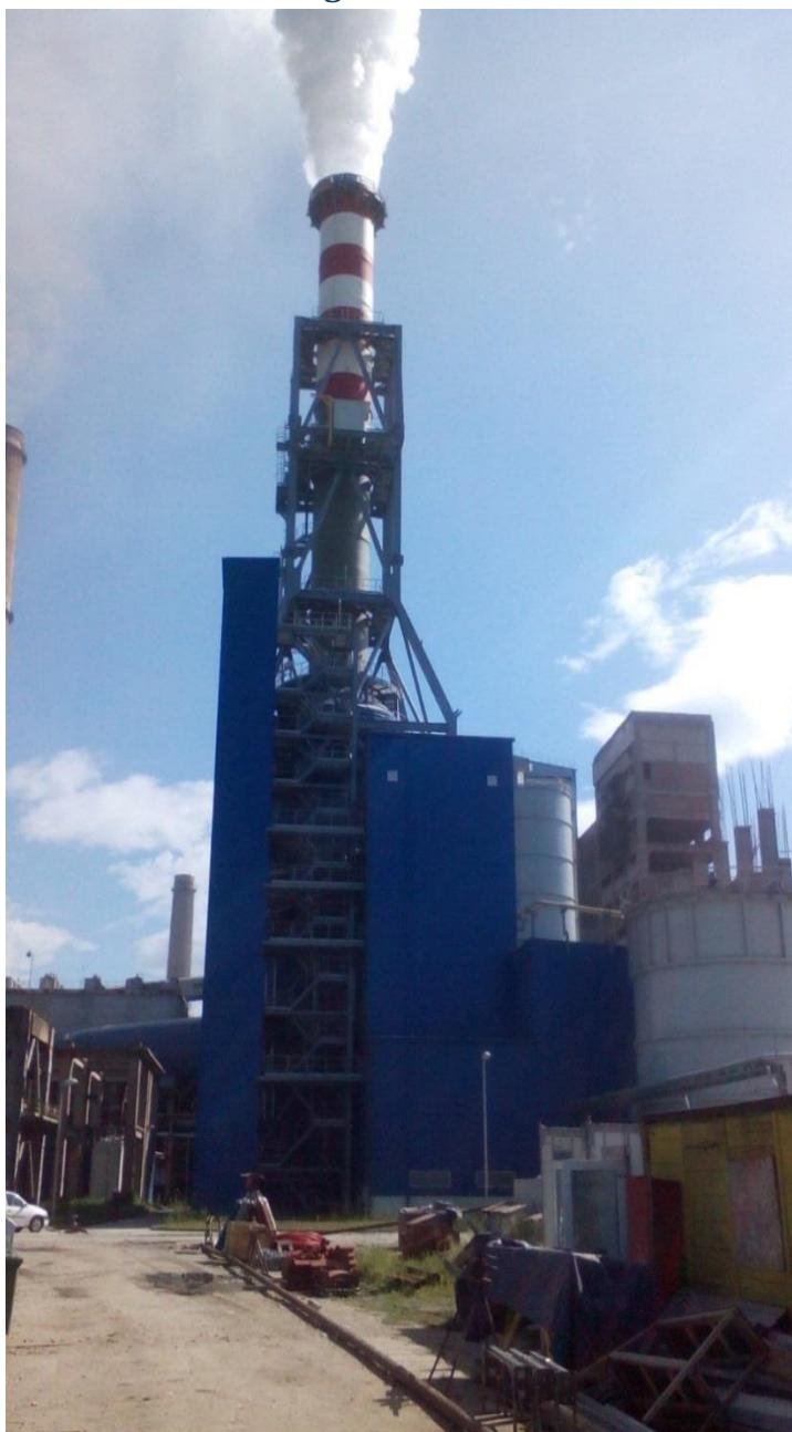
Cazanul C7 beneficiaza, incepind cu iunie 2016, de o noua instalatie de desulfurare a gazelor de ardere si respecta limitele impuse de legislatia de mediu pentru emisiile poluante de bioxid de sulf in atmosfera (243 [mg/Nm<sup>3</sup>] (miligrame per metru cub de gaze de ardere evacuate corectat pentru continut normale (zero grade celsius si o atmosfera) si pentru un continut normat de 6% oxigen in gazele de ardere).
